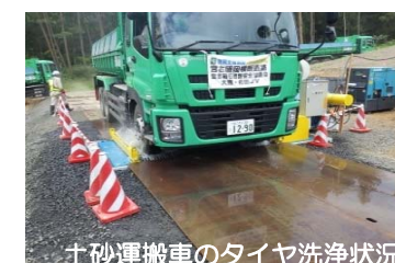
土砂運搬車のタイヤ洗浄状況
