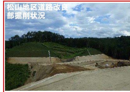
③施工：刈屋建設
