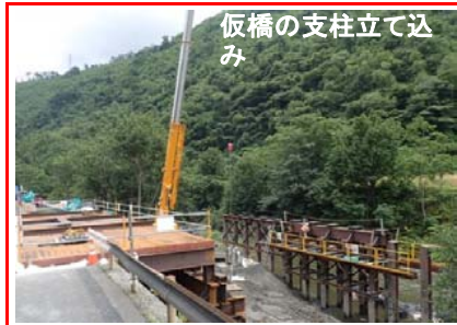
⑦施工：安藤・間
