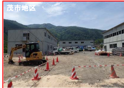
⑧施工：戸田・岩田地崎JV
