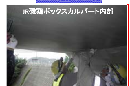
①施工：森本組
